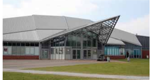
Seidensticker Halle Werner-Bock-Straße
